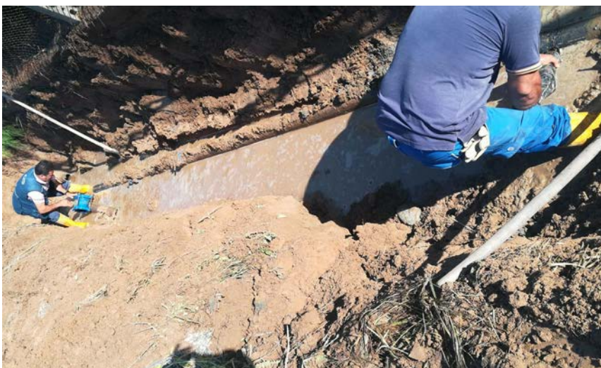
Addetti della bonifica durante lavori di manutenzione, Corigliano Rossano (Cs)
