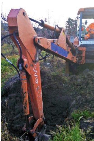
Attività di bonifica, riparazione condotta principale impianto irrigazione, Catanzaro Lido (Cz)
